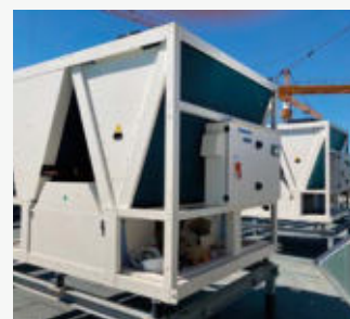
Cédus Liget. Gebäudekomplex mit Apartments, Büros, Geschäften usw. Szeged, Ungarn. ECOi-W, ECOi + Lüftungseinheiten mit Wärme- und Feuchterückgewinnung
